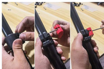
Serrer la vis pour obtenir une étanchéité adéquate
